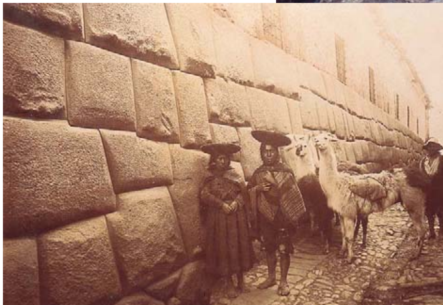
Un hato de camélidos en una calle del Cuzco a finales del siglo XIX; se puede apreciar la arquitectura incaica.
