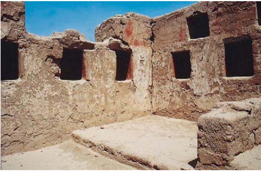
Habitación en el centro administrativo de Tambo Colorado, Ica.
